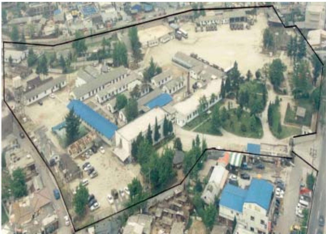
【사진 32】 국군덕정병원 현대화 前
