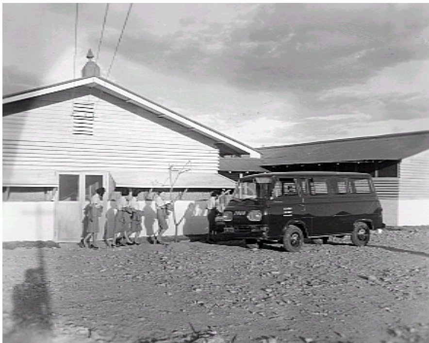
【사진 6】 제106 후송병원 간호장교 숙소
