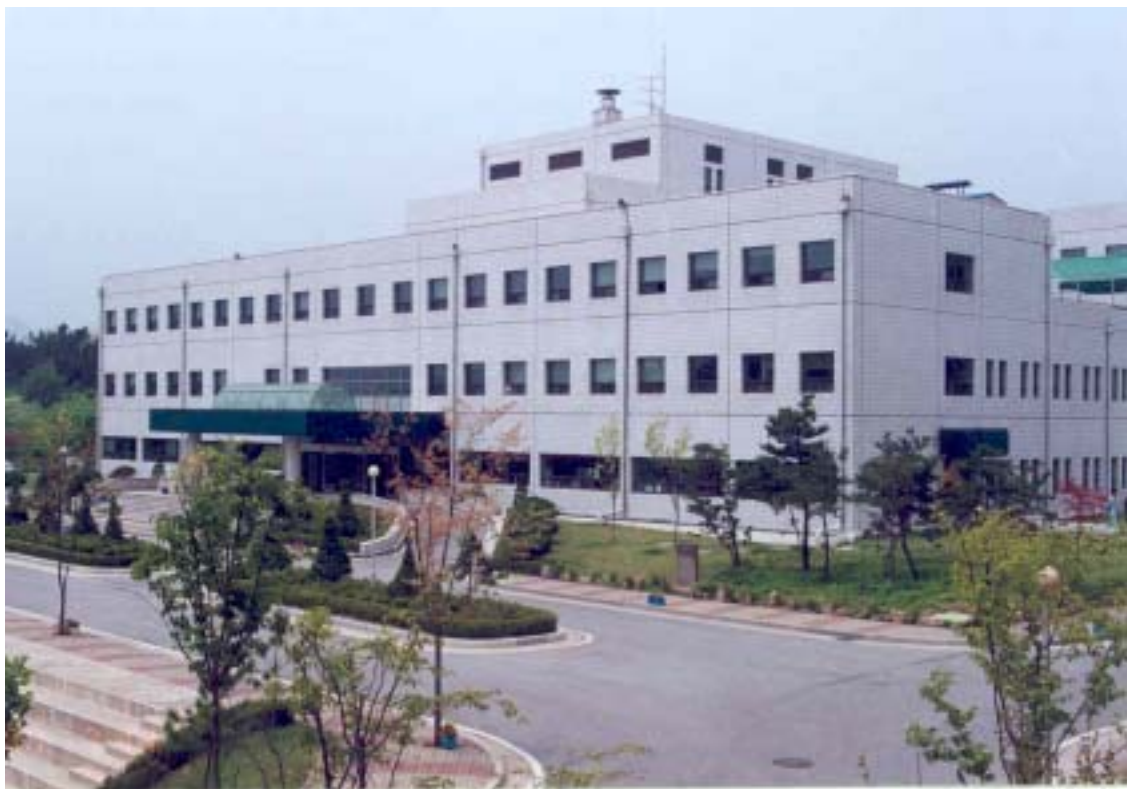
【사진 29】 국군춘천병원 현대화 後
